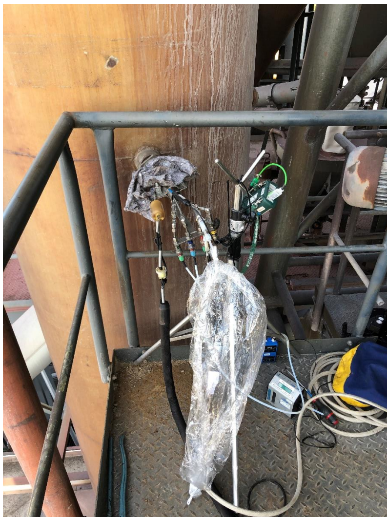
Foto 2: Meetlocatie schoorsteen AsphaltNu Den Bosch aan de Veemarktkade 10 te 's-Hertogenbosch
